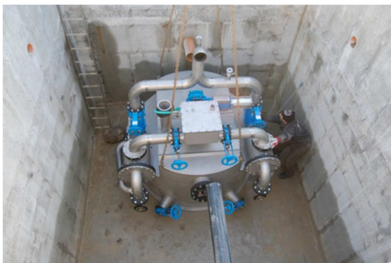
Obr. Suchá čerpací stanice – montáž
